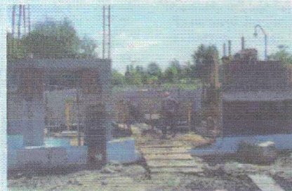
Na wielu obiektach prace modernizacyjne są już mocno zaawansowane. Ze już w okresie wakacyjnym część z nich będzie oddana do eksploatacji.
